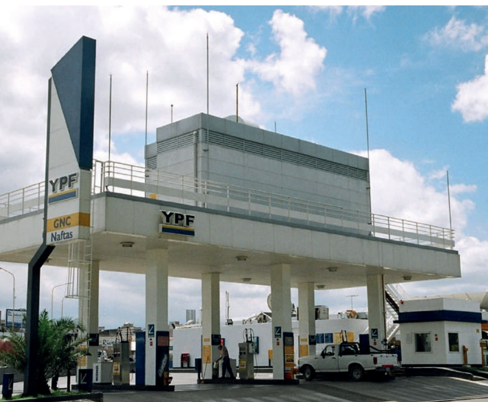
| Estación de Servicios YPF, Opressa. San Miguel de Tucumán
