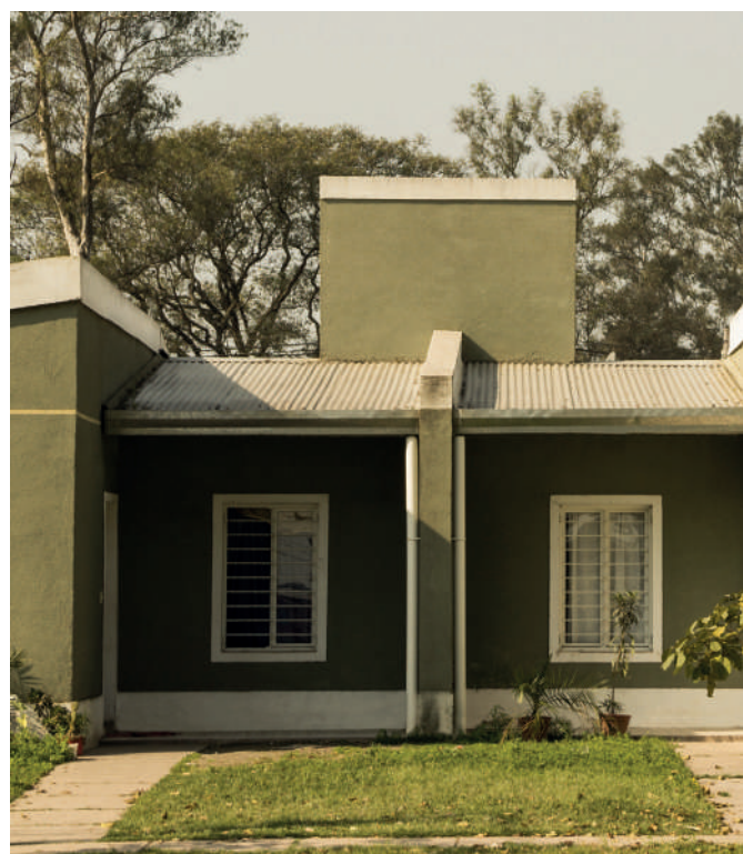
| B° 180 Viviendas e infraestructura en el Chañar
